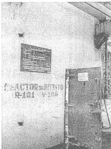
Fotografía No. 1 Cuarto del Reactor (R-101) ubicado en las antiguas Plantas auxiliares de MONOMEROS.
